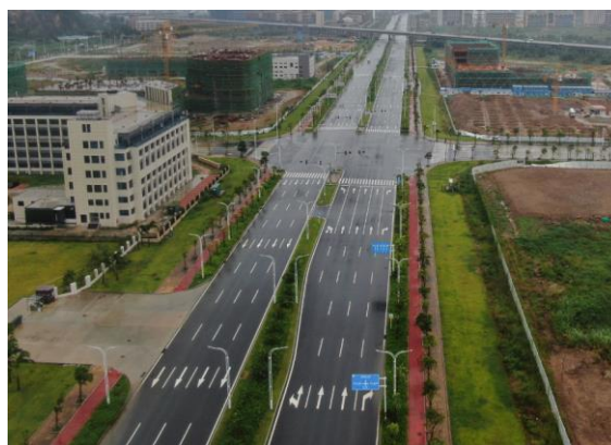
道路完工现状
