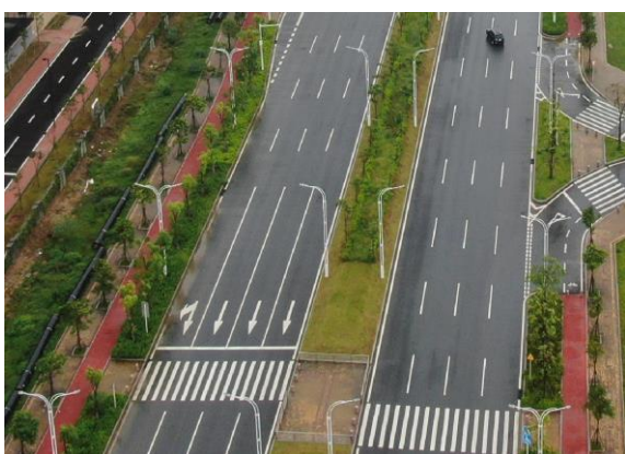
道路完工现状
