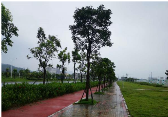
道路完工现状
