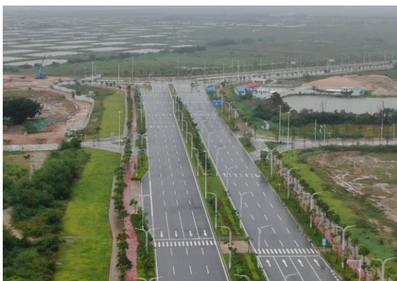
道路完工现状
