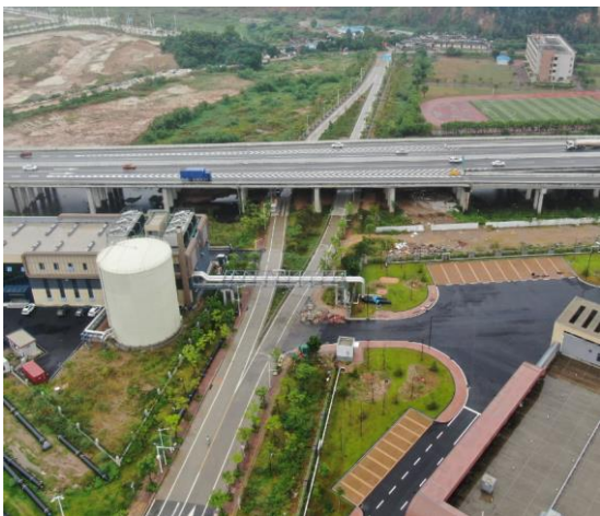
道路完工现状
