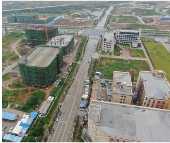
道路完工现状
