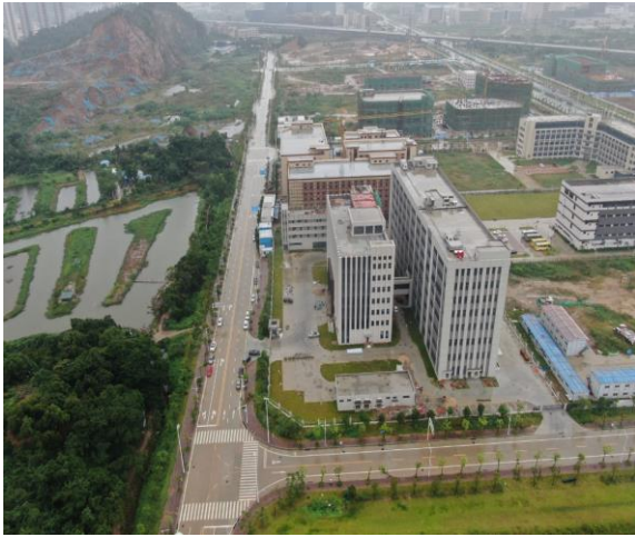
道路完工现状
