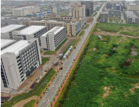
道路完工现状
