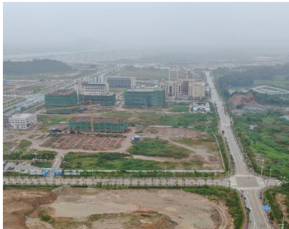
道路完工现状
