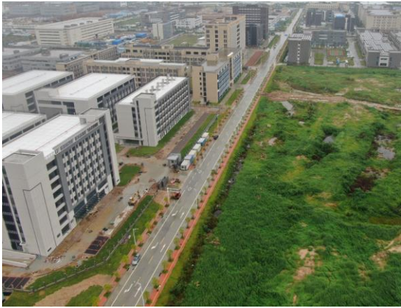
道路完工现状
