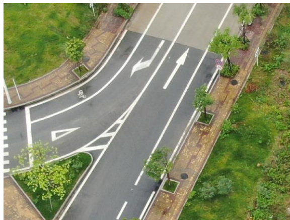
道路完工现状
