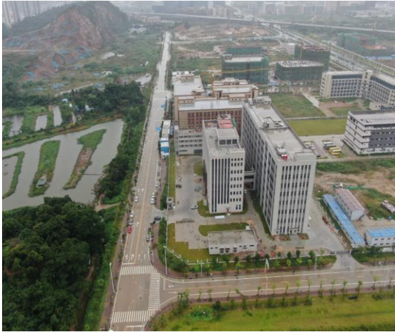
道路完工现状
