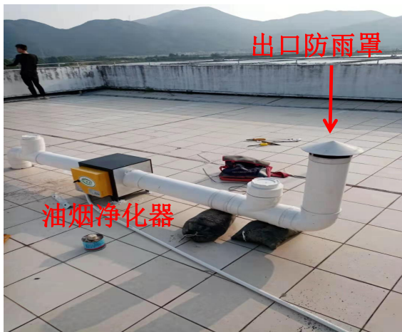
图 7.4-2 (三楼) 楼顶油烟净化器及检测孔布置
