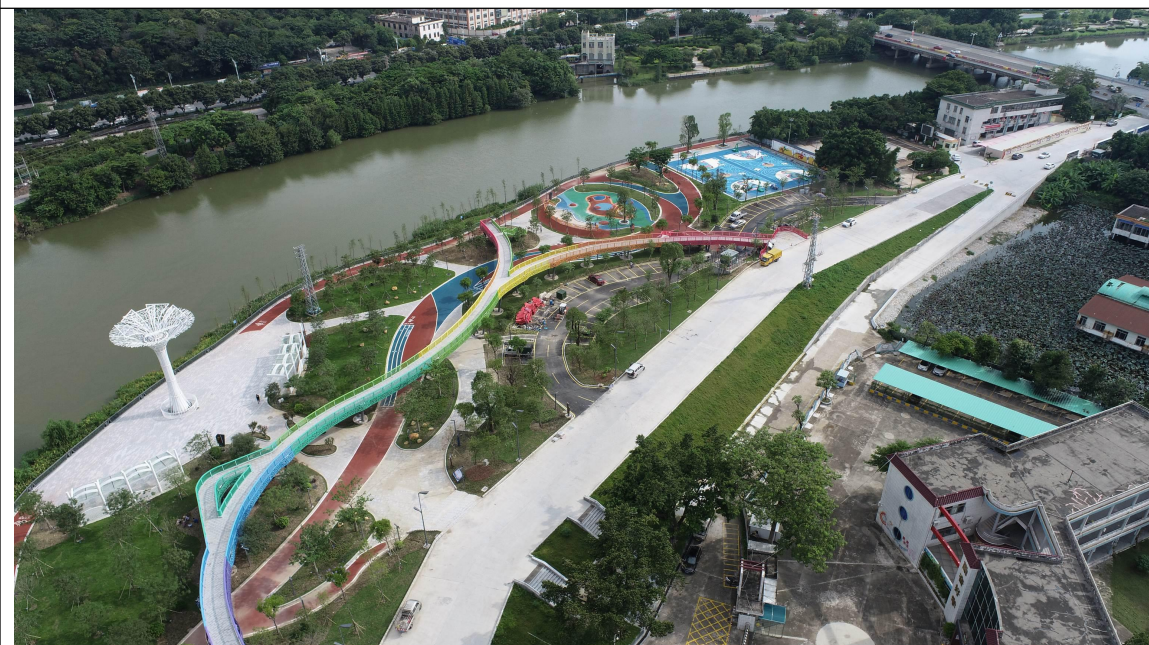
位置: k0+000~k0+280 现场: 可绿化区完成植草护坡工程, 植被恢复较好
