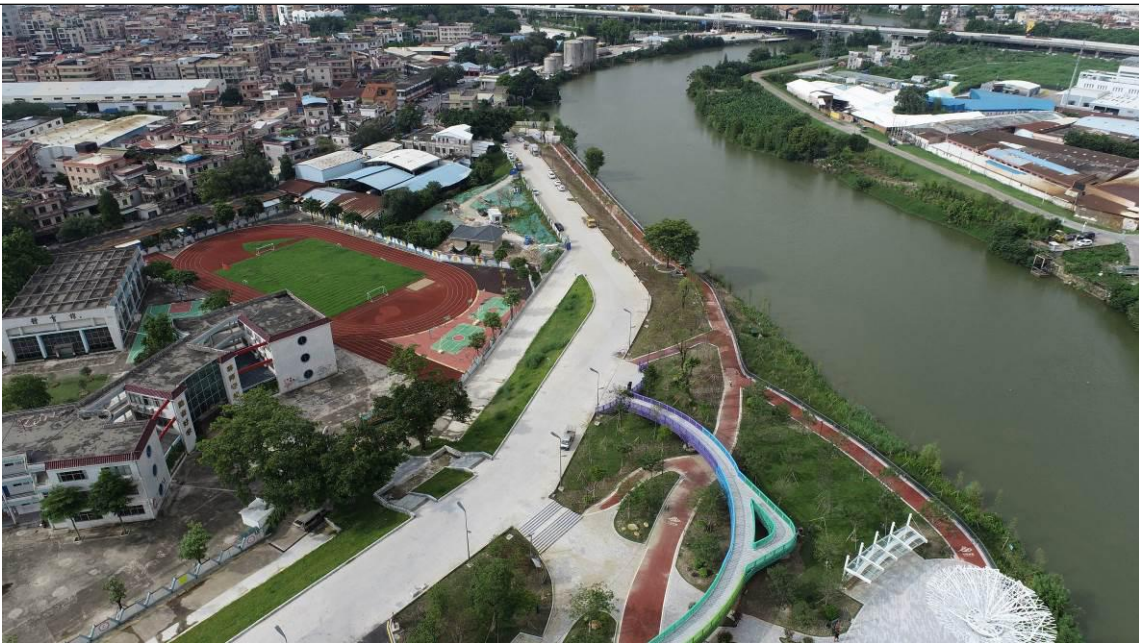
位置: k0+300~终点 现场: 可绿化区完成植草护坡工程, 植被恢复较好
