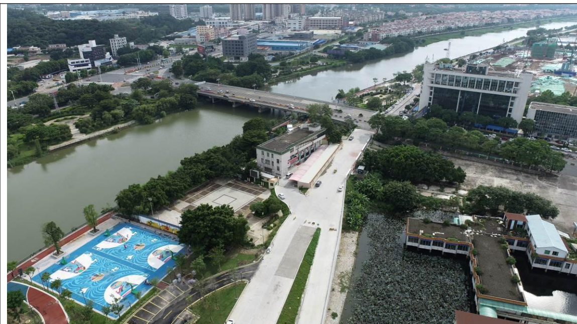
位置: k0+000~k0+150 现场: 可绿化区完成植草护坡工程, 植被恢复较好
