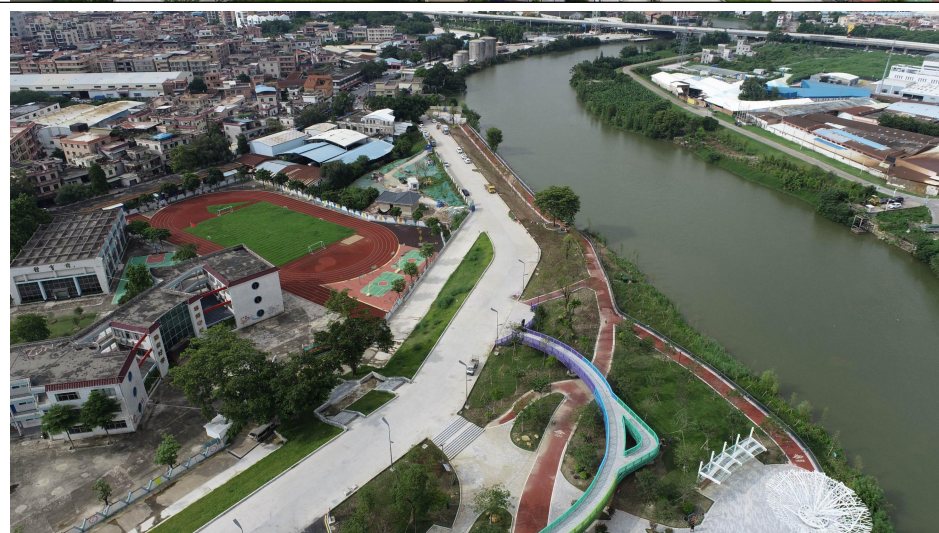
位置：堤岸工程区 照片时间：建设后，2021年8月
