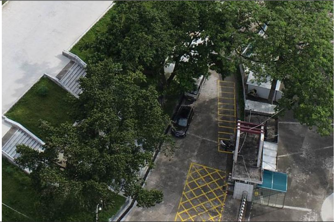
位置: k0+260~k0+300 现场: 学校门口排水明渠
