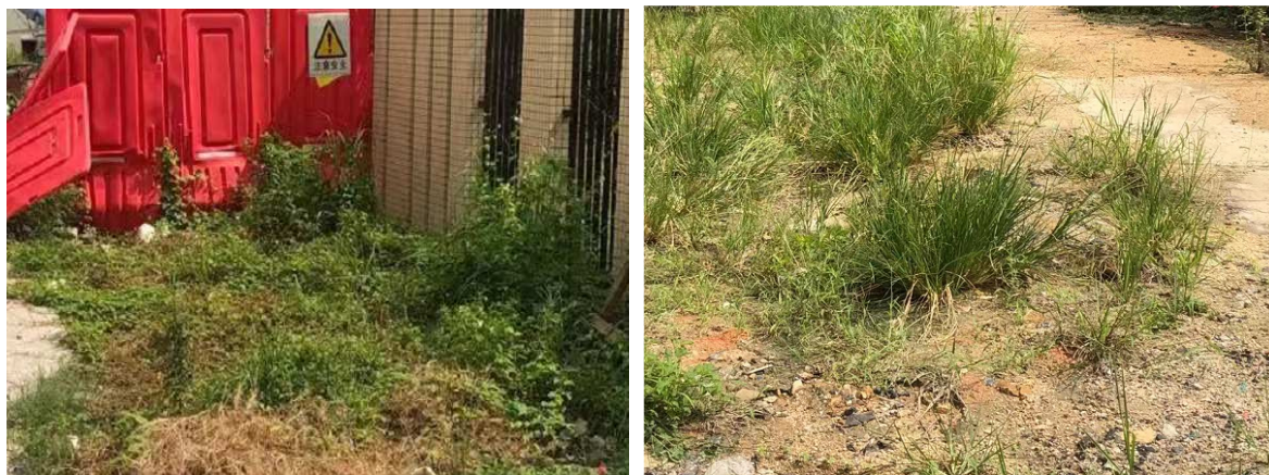
代征道路区完成绿化工程现状
