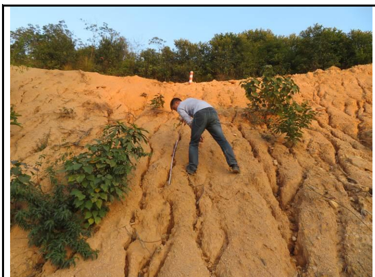
TJ11 标填方边坡侵蚀沟测长
